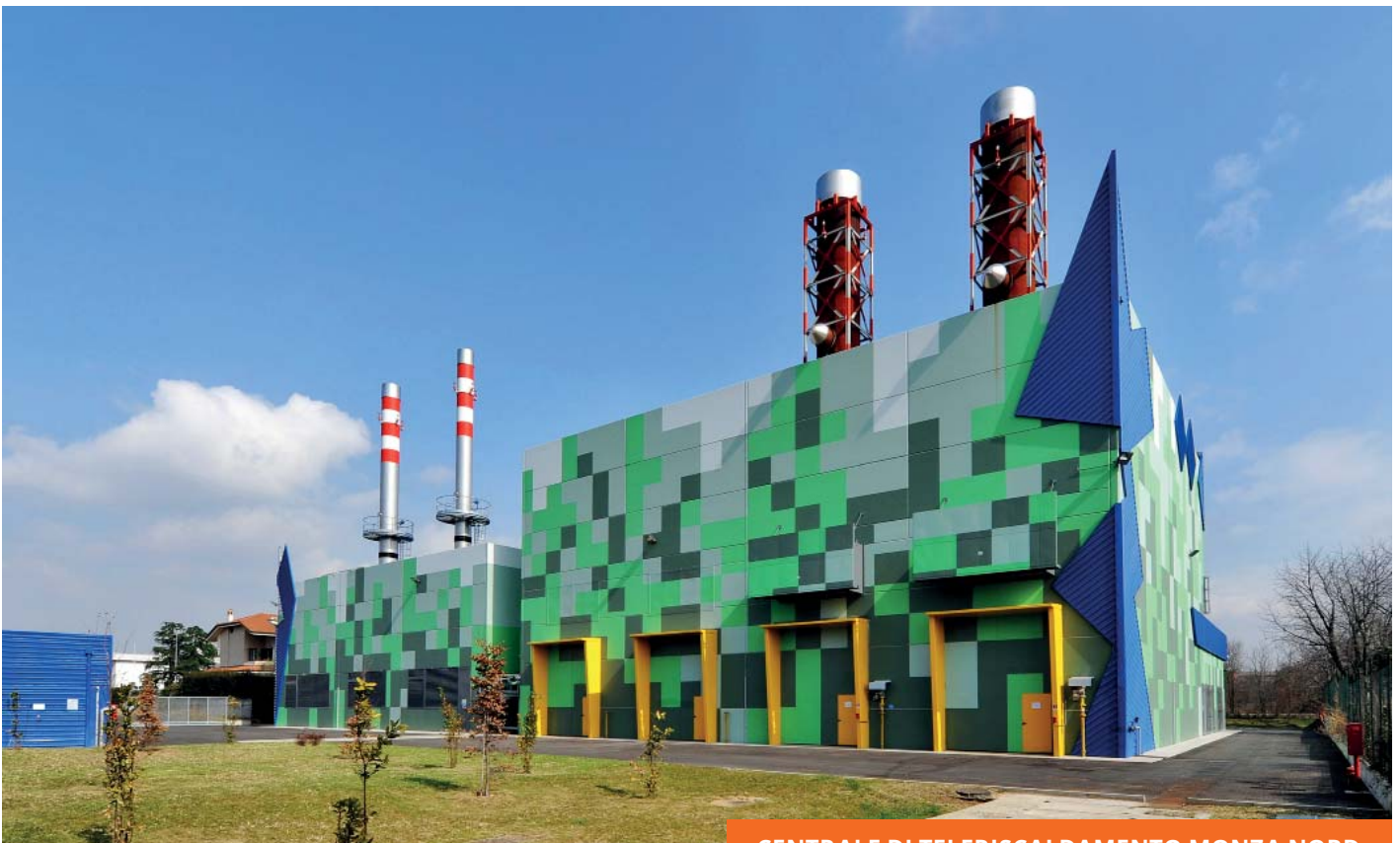
CENTRALE DI TELERISCALDAMENTO MONZA NORD
